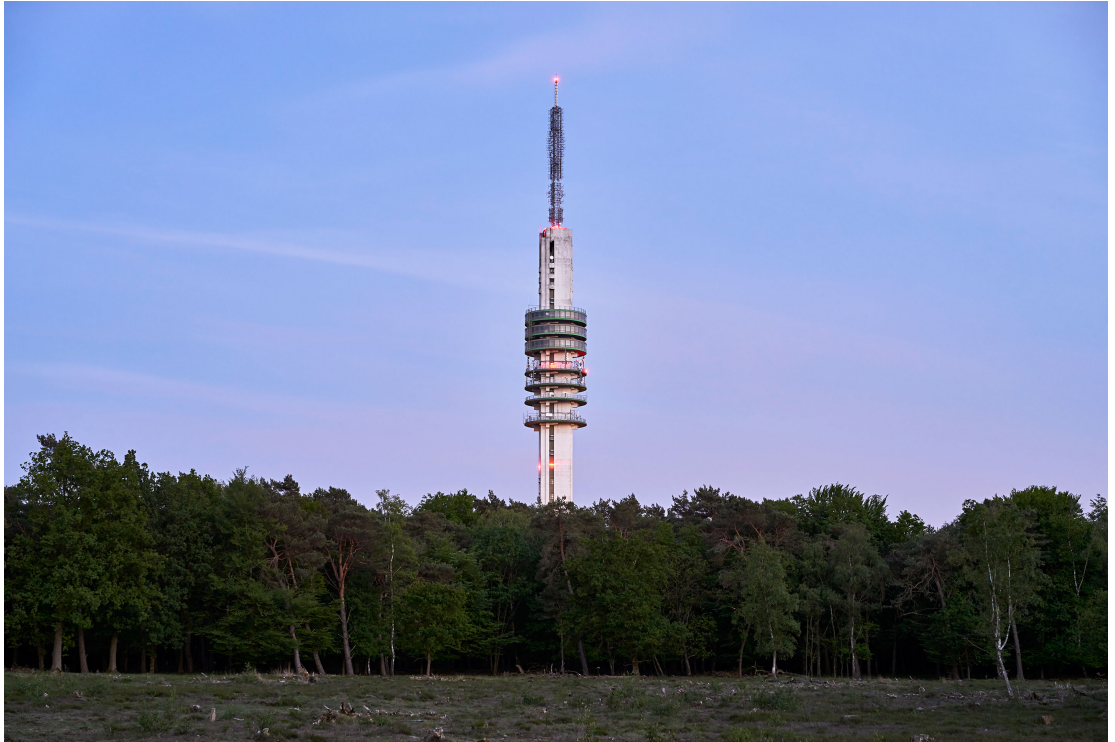
Alticom Datacenter, Hilversum.
